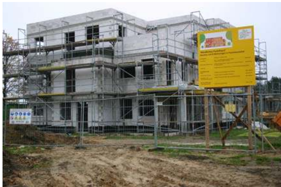
Rohbau mit Porenbeton
