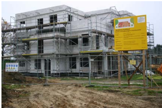
Rohbau mit Porenbeton
