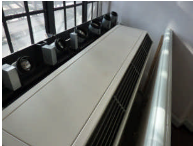
(Abb 11) Grund- und Veranstaltungsbeleuchtung hinter den Umluftheizkörpern in den Fensternischen
