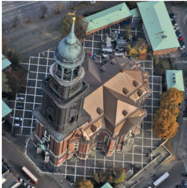
(Abb 1) Luftbild 2009 nach Dachsanierung (Foto: Michael Zapf)
